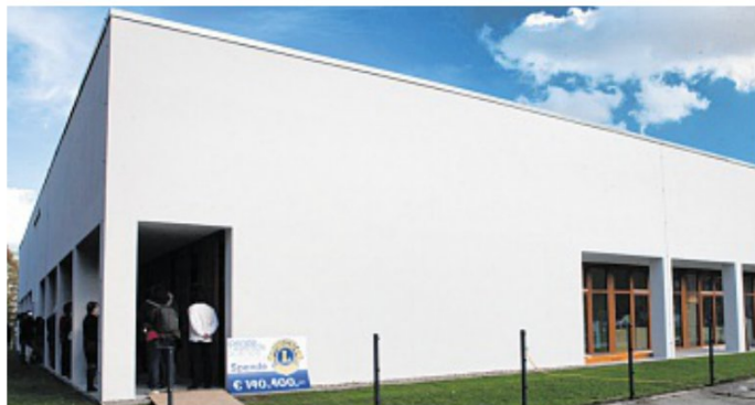
Im Oktober 2019 begannen die Arbeiten für das Hospiz. Jetzt steht es bereit.
